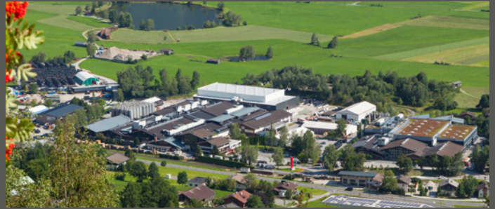
Senoplast Klepsch & Co. GmbH · Piesendorf · Austria · Headquarters
