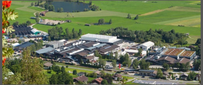
Senoplast Klepsch & Co. GmbH · Piesendorf · Austria · Headquarters
