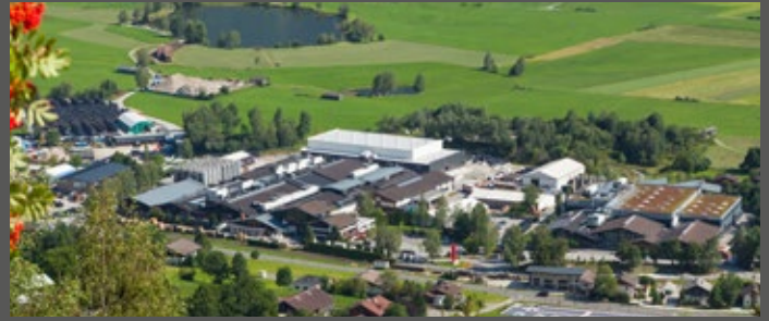
Senoplast Klepsch & Co. GmbH · Piesendorf · Austria · Headquarters
